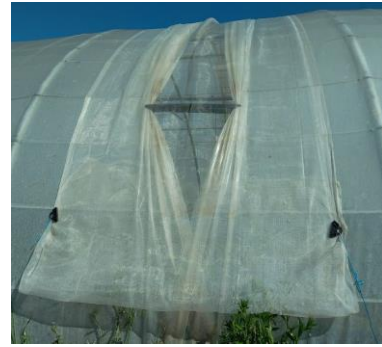
Filet au niveau des ouvrants d'aleurodes Photo CA30
