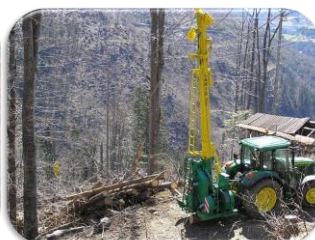
Câble aérien © France Bois Forêt
