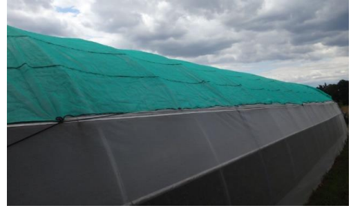
Tunnel avec filet d'ombrage – Photo CA 30
